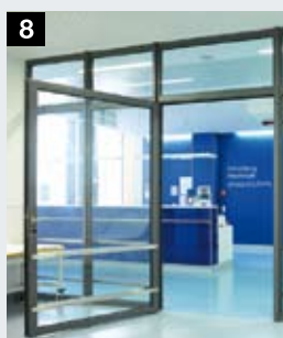
8 Огнестойкие и дымопроницаемые элементы трубчатой рамы
